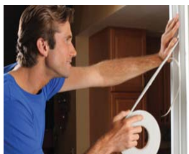
Fig 2. Inserimento guarnizioni
