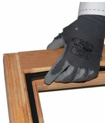
Inserire la guarnizione nel canalino e spingerne lievemente la parte tranciata contro l'altra guarnizione, in modo da evitare di lasciare fughe scoperte
