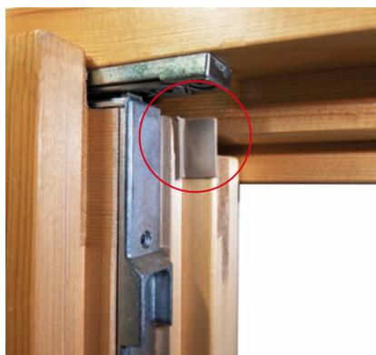
La pinna copre ora la fuga fra il montante centrale della seconda anta e i traversi inferiore e superiore (in figura il dettaglio superiore)
