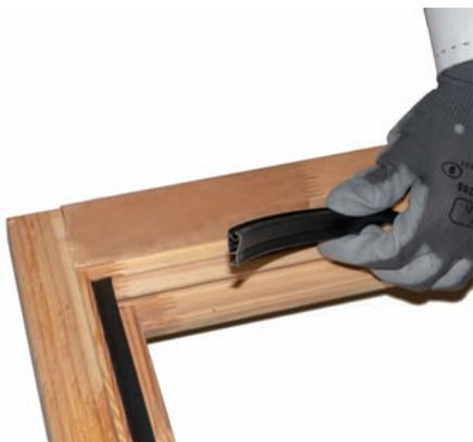
Tagliare la guarnizione con qualche millimetro di abbondanza in modo che, una volta inserita, eserciti una lieve pressione contro l'altra guarnizione ed eviti così di lasciare fughe scoperte
