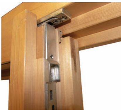
In una finestra a 2 ante, i punti maggiormente a rischio di passaggio di aria o acqua sono quelli fra il montante centrale della seconda anta e i traversi inferiore e superiore (in figura il dettaglio superiore)
